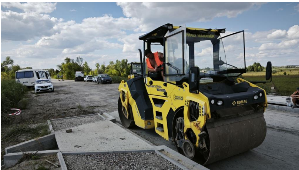
Рисунок 4 — Ущільнення укріплених цементом щебенево-піщаних сумішей
