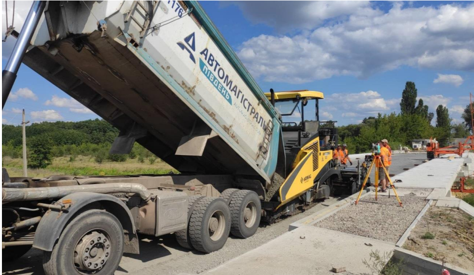
Рисунок 3 — Укладання укріплених цементом щебенево-піщаних сумішей
