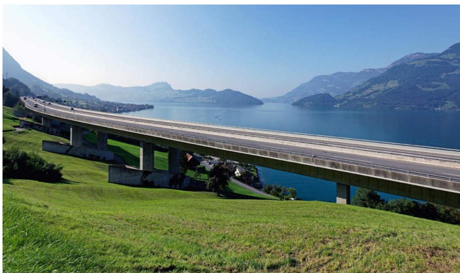
Рисунок 2 — Віадук Беккенрід-Ленен, Швейцарія [4]
