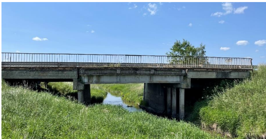
Рисунок 2 — Загальний вид залізобетонного мосту
